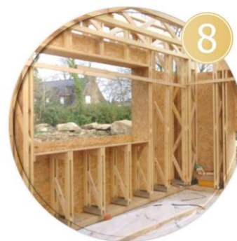
8 Travaux de gros œuvre
